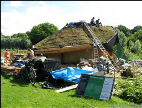
Nils Norman, kunstproject 'Eetbaar Park'. Aanleg groen dak.
