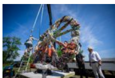
Plaatsing Molenvlietpark_fotografie Martijn Beekman_1.jpg
